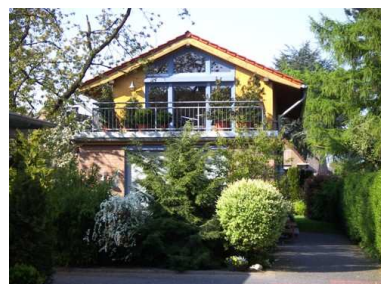
Wasser in den Fenstern Haus Ballhausen
